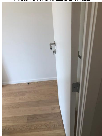
Photo 18 : WC HALL D'ENTRÉE
